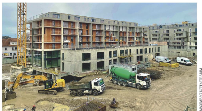
Les travaux de cloisonnement ont démarré sur la partie inférieure des immeubles avant l'achèvement complet du gros œuvre.
